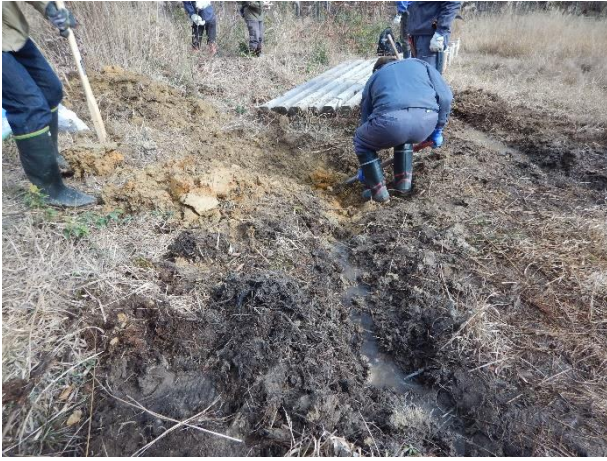
第4湿原観察台先端への導水作業
