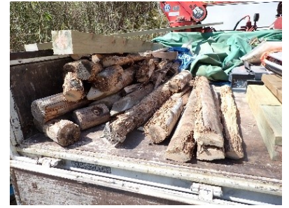
解体束柱処分（持ち帰り）
