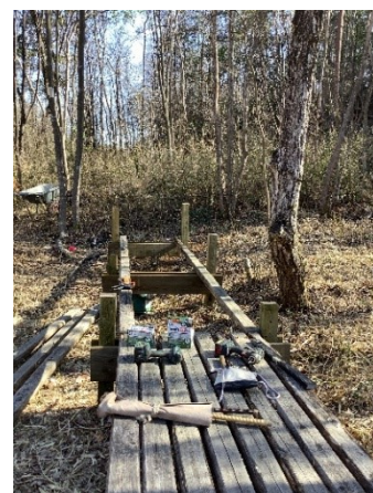
踏み板の組み換え
