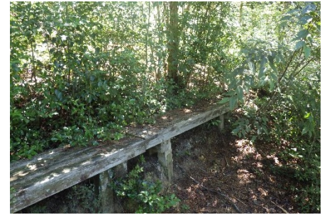
作業前 木が覆いかぶさっているベンチ
