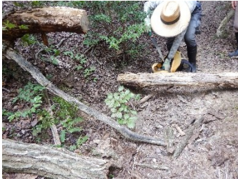
手鋸で切断その後撤去
